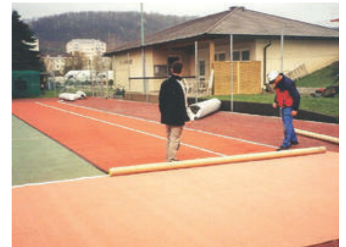
Die Arbeiten für die Errichtung des neuen Belags 2022 beginnen.
